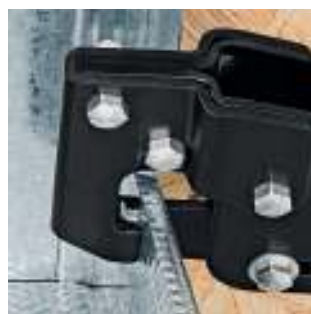
Nasazení kleští na dva spojované profilované plechy
